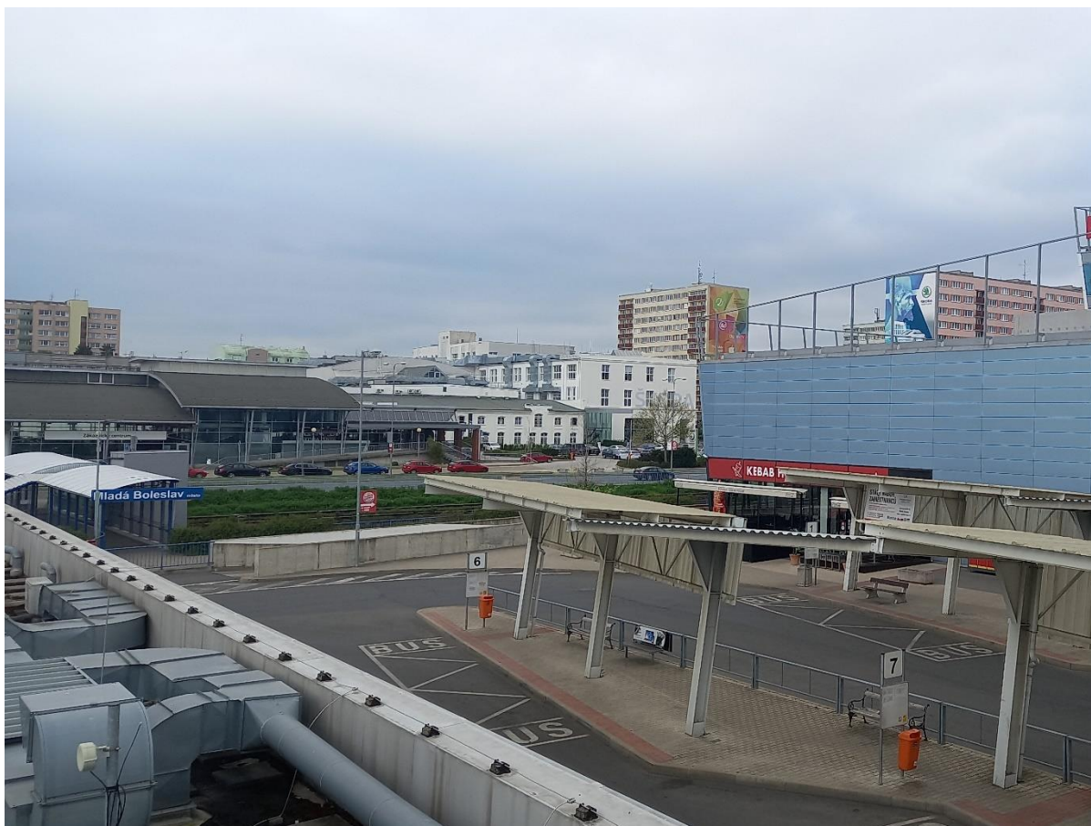
Nedostatek zeleně v okolí nákupního centra Bondy a autobusového nádraží (autor: Mgr. Oldřich Sklenář, ASITIS s.r.o.)
