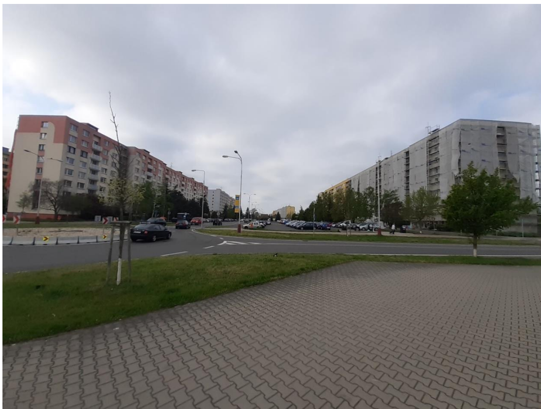
Návrh na revitalizaci ploch zeleně a novou výsadbu v sídlištích - Severní sídliště (autor: Ing. Martin Vokřál, ASITIS s.r.o.)
